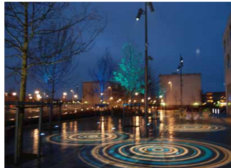
Eksempel på effektbelysning. Master med flere armaturer belyser pladsen, hvor et filter i armaturet giver mønster på belægningen. Træer er belyst med uplights (blå og turkis), som er indbygget i belægningen. Mulighederne for belysning er mange. Klydens Plads, Ishøj.
