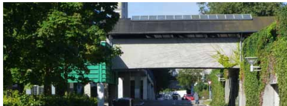
Intern gangbro, der forbinder afdelingerne fra rækkehusdækket til lavhusniveauet, spænder over den underliggende servicevej. Billedet viser det lukkede udtryk gangbroerne generelt har.
