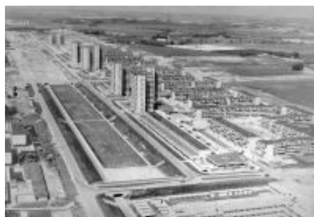
Brøndby Strand Parkerne under anlæg i slutningen af 1960'erne. Der blev hurtigt opført mange boliger med ny byggeteknologi. Foto fra Forstadsmuseet.dk
