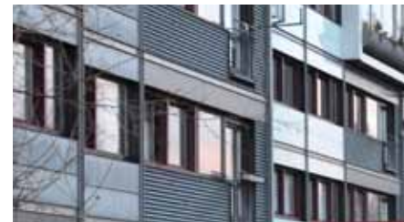
Renoveret østfacade med nye materialer.
