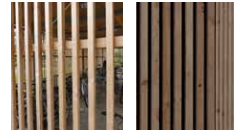
Beklædningen skal forholde sig til de kommende ombygninger og til de nye cykelskure i gårdrummene.
