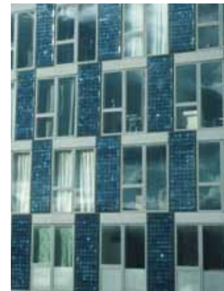
Der kan arbejdes med solceller som en integreret del af facadeudtrykket. Her eksempel fra kollegium på Silkeborgvej Århus.
