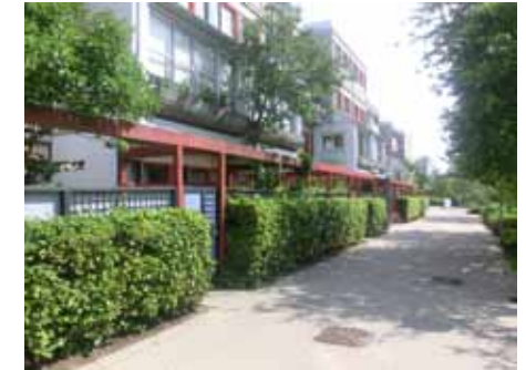
Pergolaer med den karakteristiske røde trækonstruktion, her yderligere afgrænset af hæk i BB.
