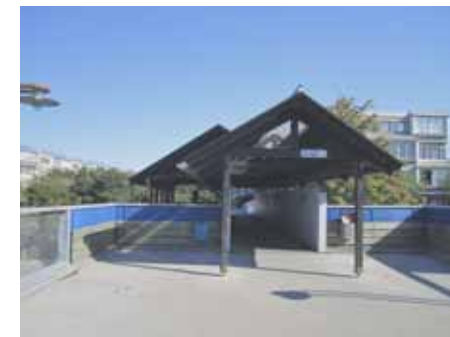
En af de mange overdækkede broer, der rækker over det underliggende p-område og servicevejen, og forbinder området ved lavhusene med området med rækkehus og højhuse.
