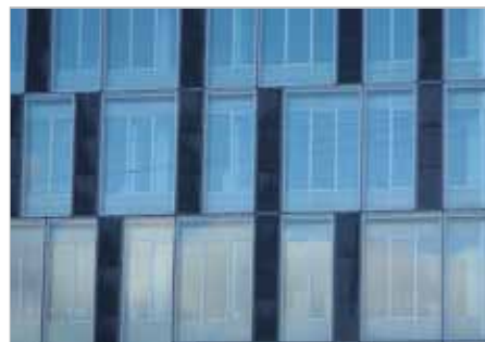
En udenpåliggende klimaskærm kan skabe nyt liv i facaden. Her erhversbyggeri ved Langebro i København.
