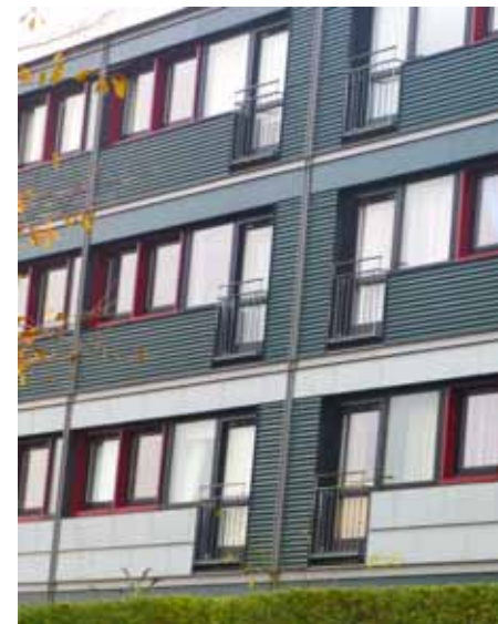
I de renoverede nordfacader er de eksisterende vinduesformater bevaret. Franske altaner skaber en ny rytme i facaden Her fra BB.
