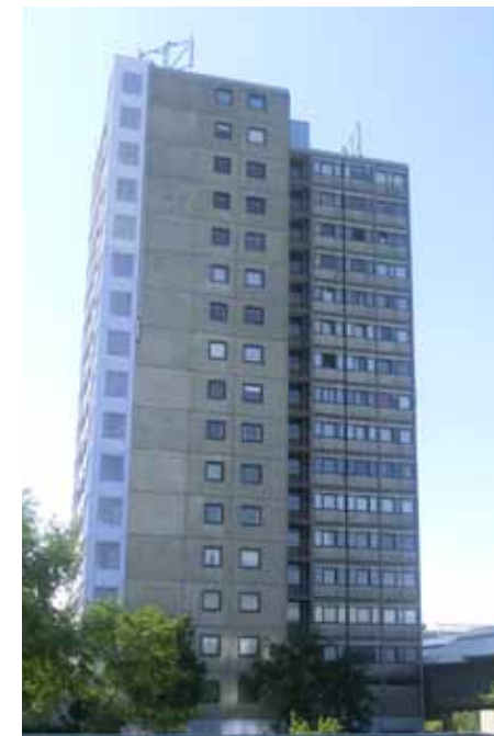
Det lodrette stablingssystem ses tydeligt i højhusenes modulopbygning. De farvede elementer er lette facadepartier, som rummer altanerne. Den højre del af facaden med det vandrette vinduesbånd er også et let facadeparti med grå eternitplader, der ligner beton. Her BB.
