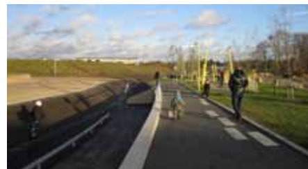
Eksempel på klimatilpasningsprojekt og skaterbane i ét. Det vil være oplagt, at der arbejdes med en løsning, hvor aktiviteter på de lavere beliggende arealer kan fungere som forsinkelsesbassiner ved skybrud. Rabalderparken, Roskilde.
