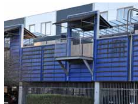
Udsigtspost i afskærmningen mellem dækket ved de nyrenoverede rækkehuse og servicegaden. Her i BB.
