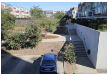
Kombineret rampe og trappeanlæg, der optimerer tilgængelighed mellem lavhusesenes boliger/fælles friareal og servicevejen, her BB.
