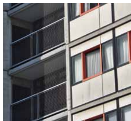
Slusen er det sted i bygningen hvor det oprindelige relief er bevaret.
