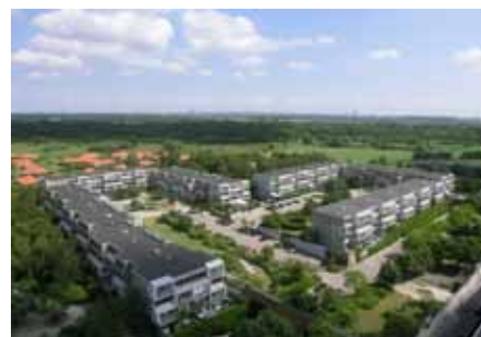
Brøndby Strand Parkerne 35 år senere og en omfattende renovering er påtrængt. Nu dukker der problemer op, som relaterer sig til nedslidning og brug af sundhedsskadelige byggematerialer ved opførelsen.
