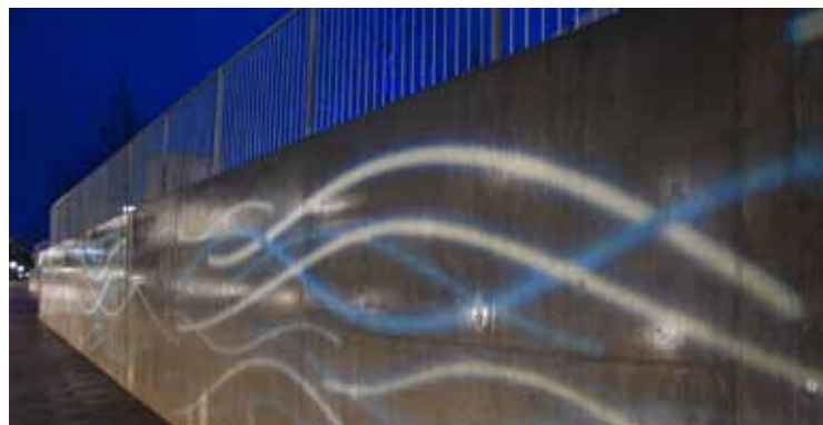
Effektbelysning med stranden som inspiration. Cykeltunnel, Ishøj Centrum.
