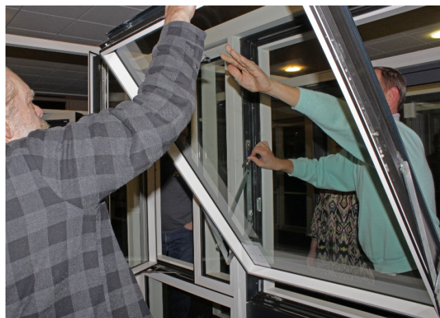
Vinduet er vendt, så det kan pudses på ydersiden inde fra boligen.
